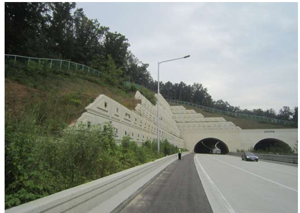
1공구 보강토옹벽(본선 STA.6+933~7+040)
