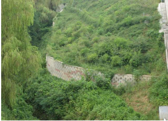
1공구 보강토옹벽(본선 STA.0+283~0+400)
