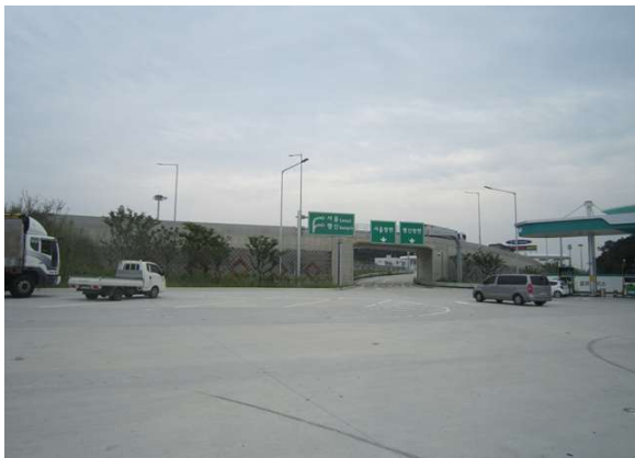
1공구 보강토옹벽(본선 휴게소통과교량)
