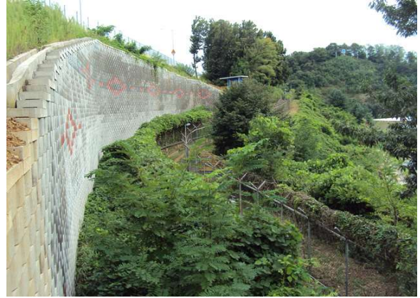
1공구 보강토옹벽(본선 STA.1+914~2+020)
