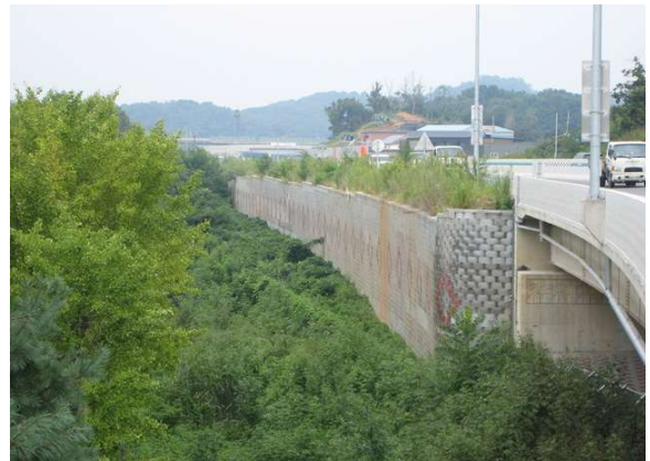
1공구 보강토옹벽(지선 STA.0+321~0.680)
