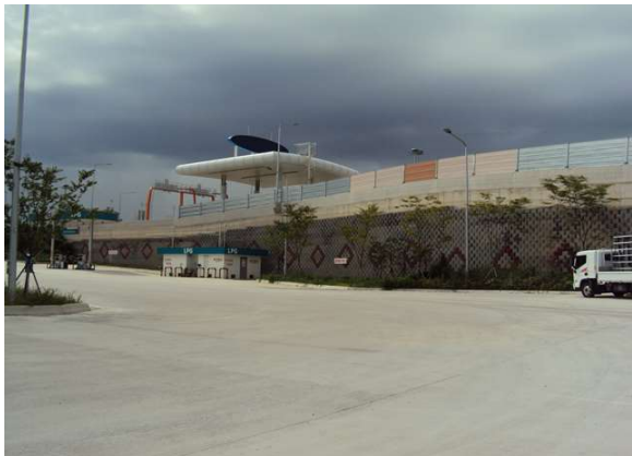
1공구 보강토옹벽(본선 STA.4+993~5+110)
